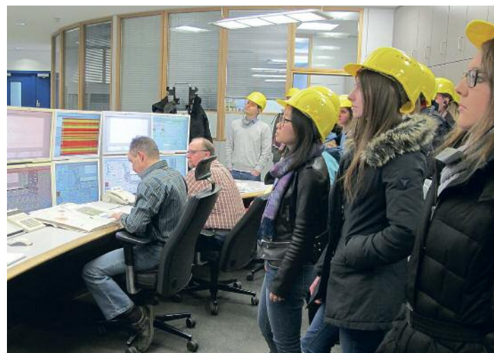
In der Schaltzentrale des Müllheizkraftwerks Coburg.
