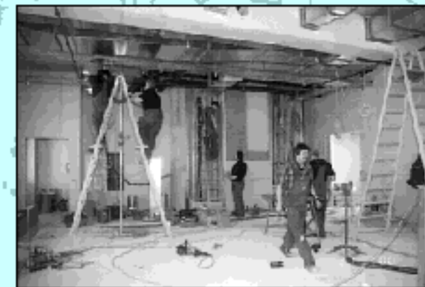
Mitte des Jahres ist der Innenausbau in vollem Gange – kilometerlange Kabel werden verlegt.
