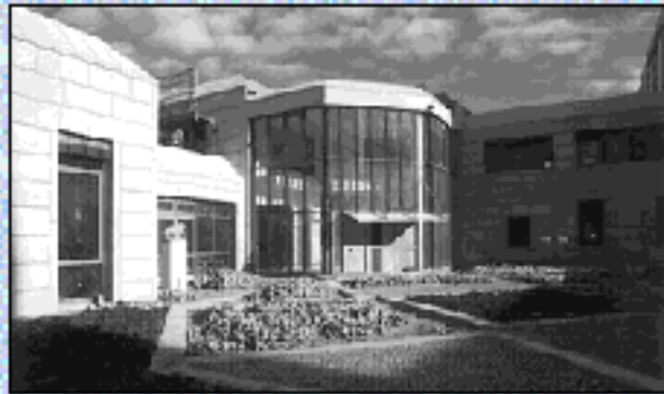
Der Haupteingang des neuen Konferenzentrums kurz vor der Fertigstellung.
