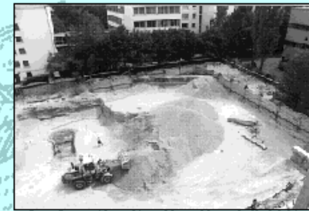
Die Arbeiten beginnen: Aushub der Baugrube im Juli 1999.
