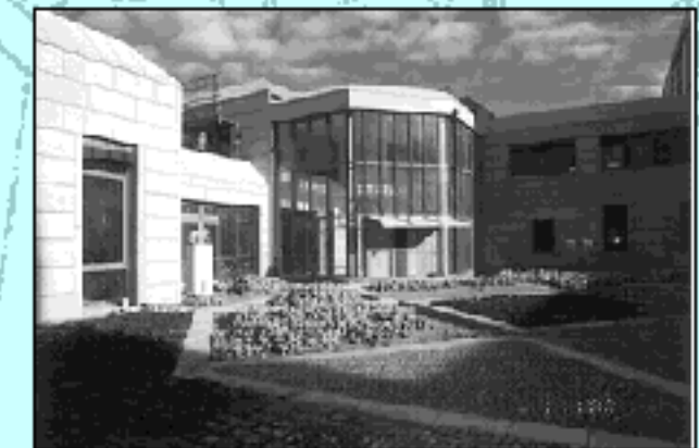
Im November 2000 haben auch der Haupteingang und die Außenanlagen schon Gestalt angenommen.
