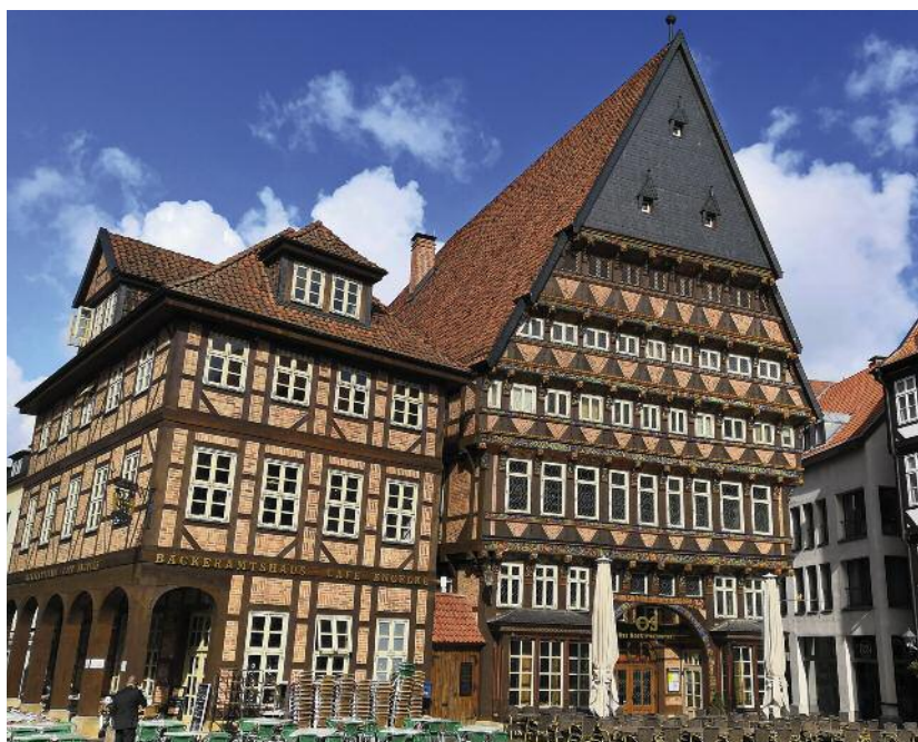
Überwiegend Nachbauten nach dem Krieg: Fachwerkhäuser in Hildesheim.
