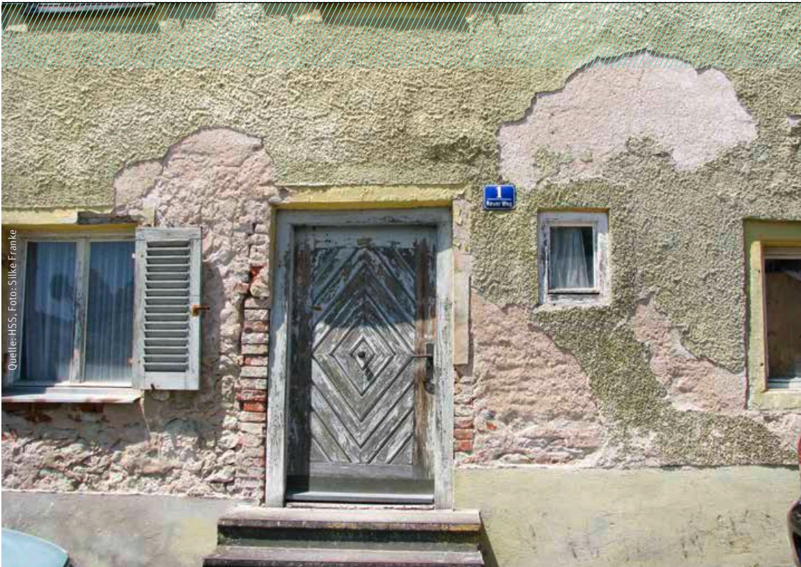
Aus Alt mach wieder Neu! Auch mit Sanierung kann man Platz gewinnen oder erhalten, z. B. dringend benötigten Wohnraum.
