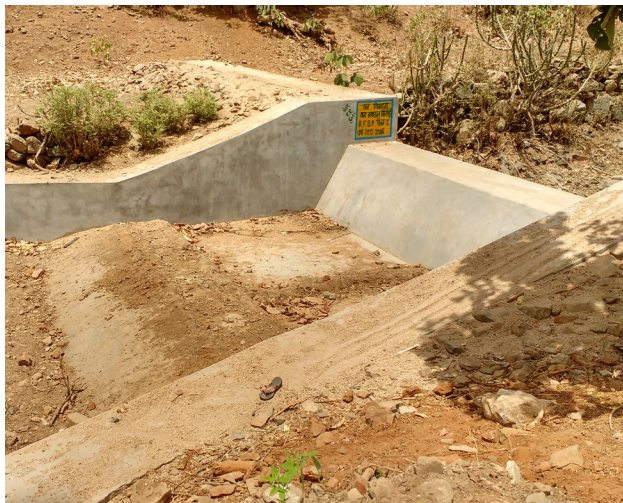
Damm in Rajasthan, der nach erfolgreicher Schulung durch Partner der HSS beantragt und errichtet wurde.
