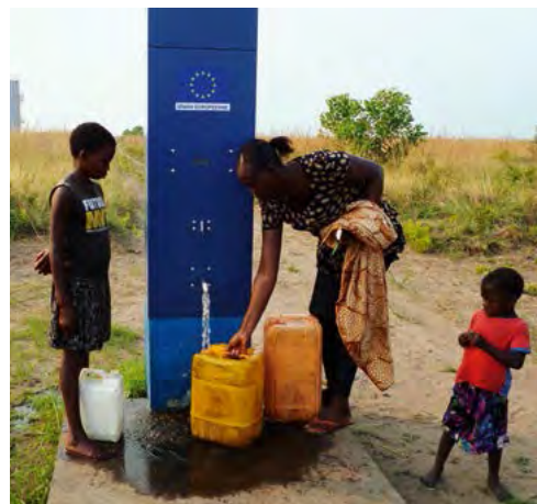
Wasserstelle im Siedlungsgebiet des EU-Projektes in der DR Kongo
