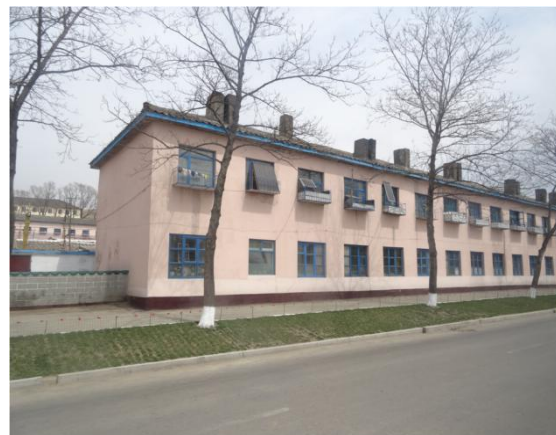
Solarmodule sind in vielen Häusern, wie hier in Rason, einfach in die Fenster gestellt, um zumindest eine primitive Energieversorgung zu gewähren. (Foto: Bernhard Seliger).
